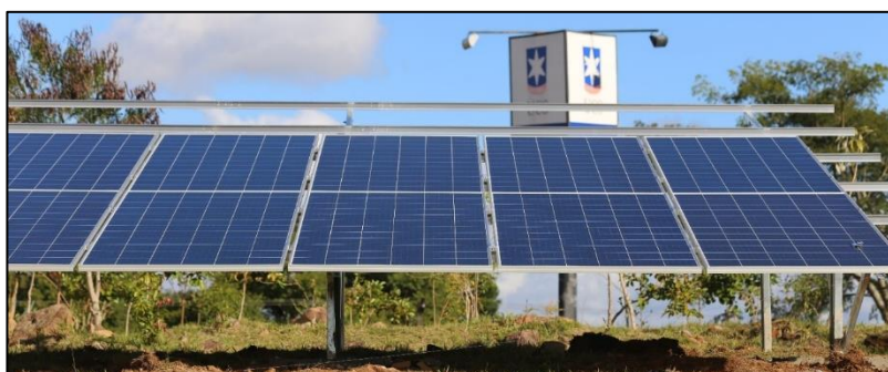
Figura 7: Módulos fotovoltaicos de 400Wp cada, com suas células solares em circuito misto, instaladas na UCS.
